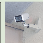
防犯カメラの設置(屋外・屋内)
